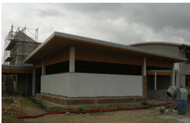
Vista del corpo D della scuola di Vergaio-Tobbiana in costruzione
