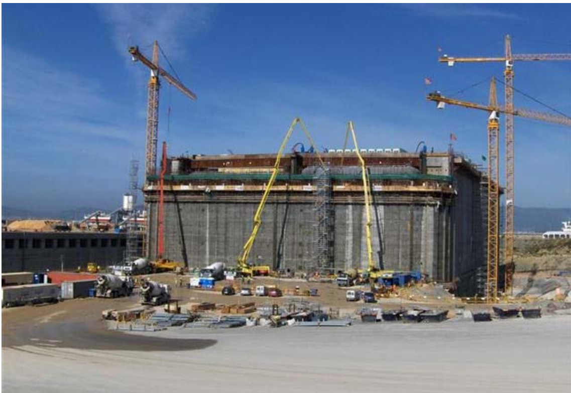
Impianto di rigassificazione dell'Alto Adriatico - Giugno 2007 - Viene completata la struttura principale in cemento armato (GBS)
