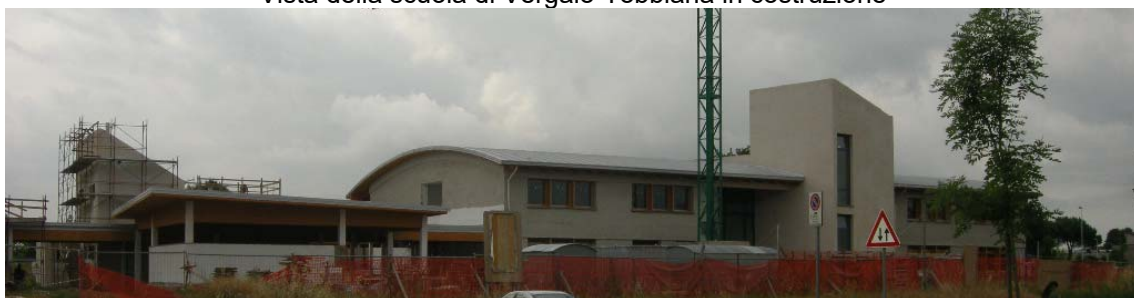
Vista della scuola di Vergaio-Tobbiana in costruzione
