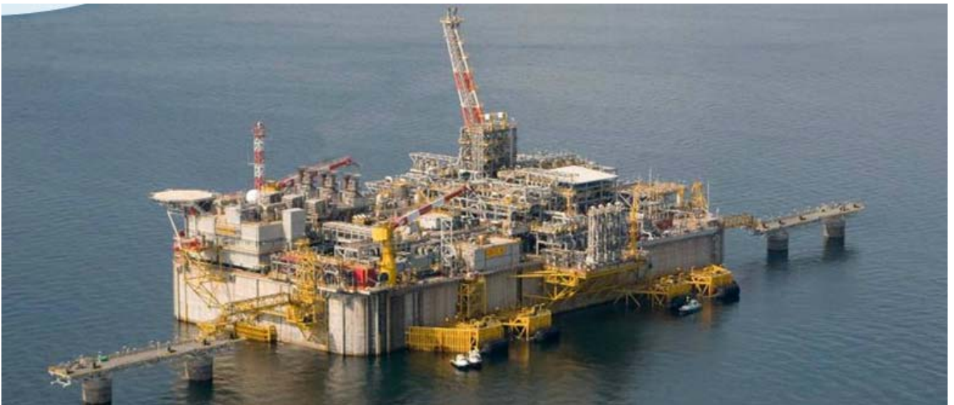
Impianto di rigassificazione dell'Alto Adriatico: lavori ultimati
