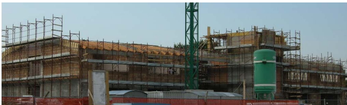
Vista della scuola di Vergaio-Tobbiana in costruzione
