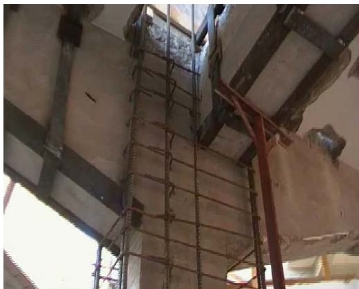
Particolare armatura pilastro e consolidamento delle travi
