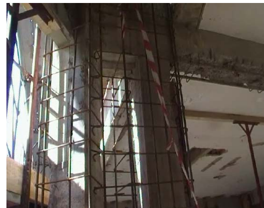
Metodologia di intervento per il rinforzo delle travi e preparazione dell'armatura della camicia del pilastro
