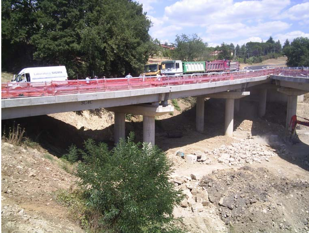
Prova di carico sul ponte Borro delle Querce per la realizzazione della Variante di Levane (Arezzo)- Collaudatore: Prof. Ing. Andrea Vignoli- Committente: Provincia di Arezzo
