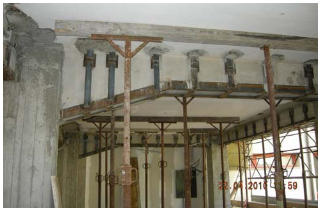
Particolare armatura pilastro e consolidamento delle travi
