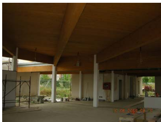
Vista interna del corpo D della scuola di Vergaio-Tobbiana in costruzione
