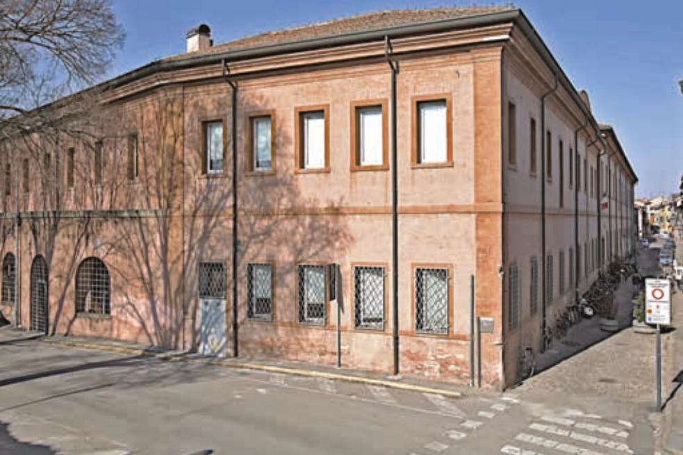
Visione d'angolo tra via Quartieri e via Baluardi.
